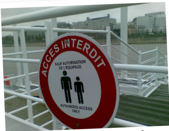
UNE SIGNALÉTIQUE INCOMPLÈTE
